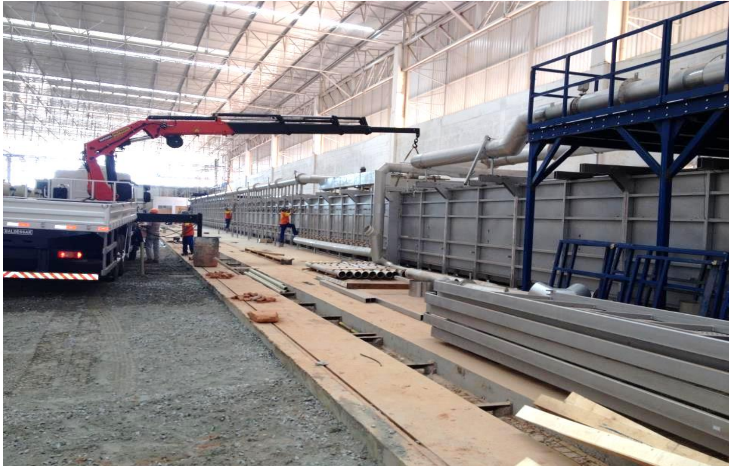
Montagem do forno contínuo
