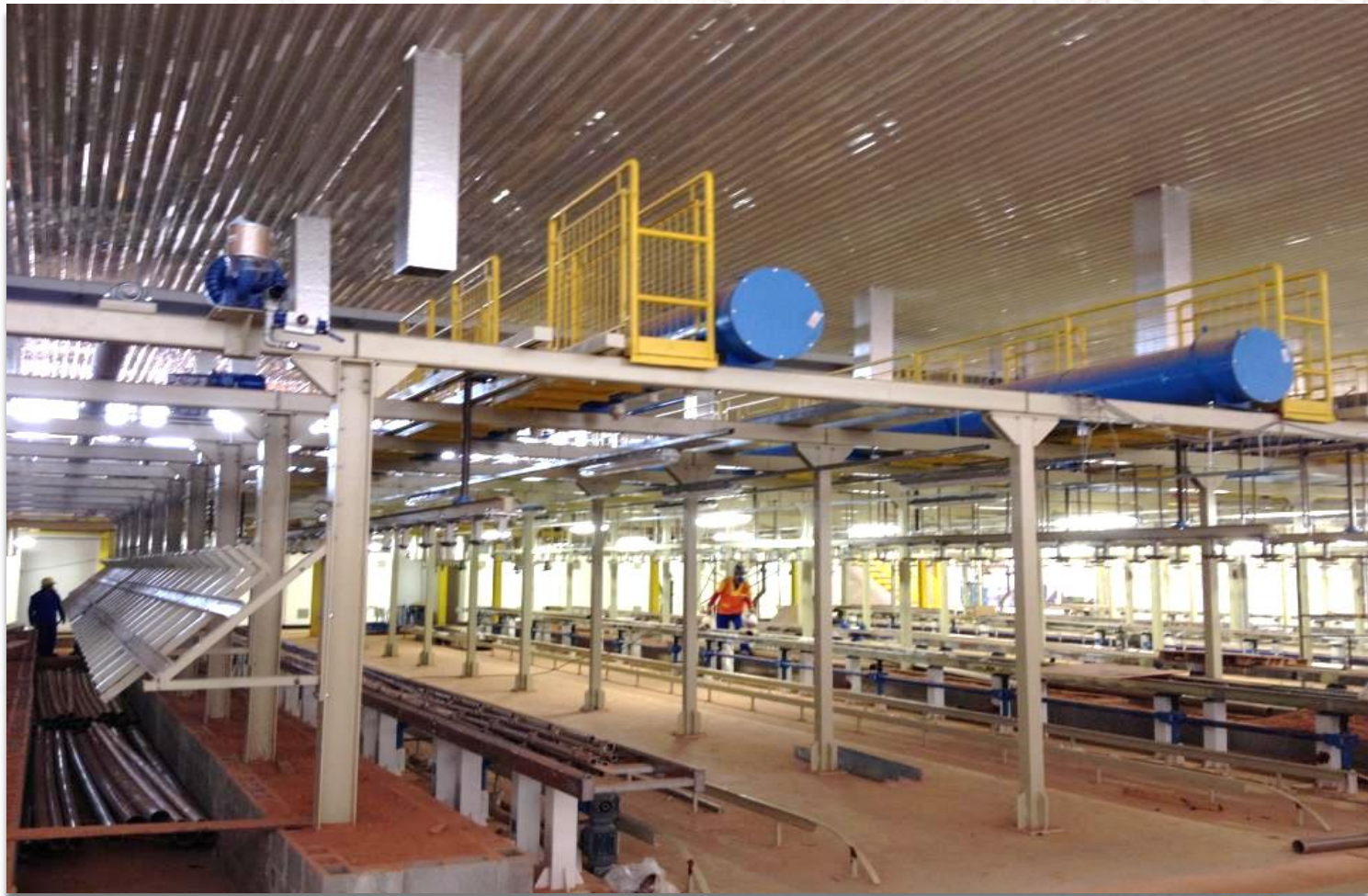
Montagem das bancadas
