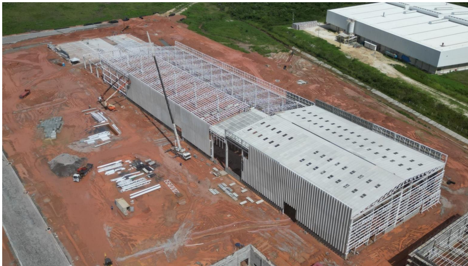
Unidade de fibrocimento em construção - Caucaia/CE
