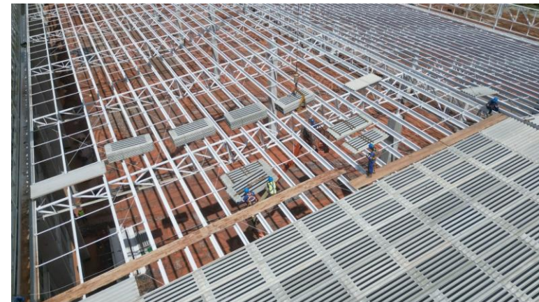
Implantação das telhas solares de fibrocimento – Caucaia/CE
