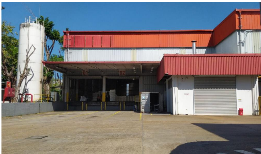
B – Manutenção e Almojarifado
