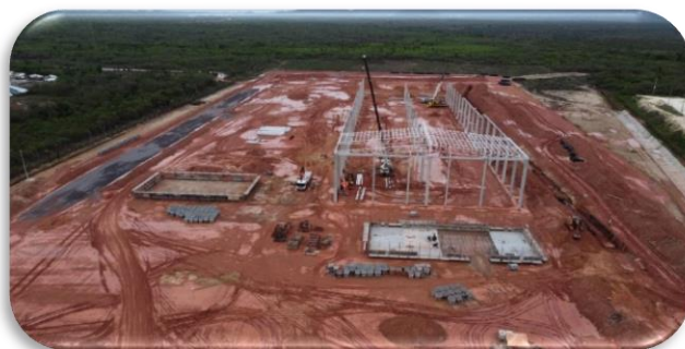
Construção Caucaia-CE (Dez/22)
