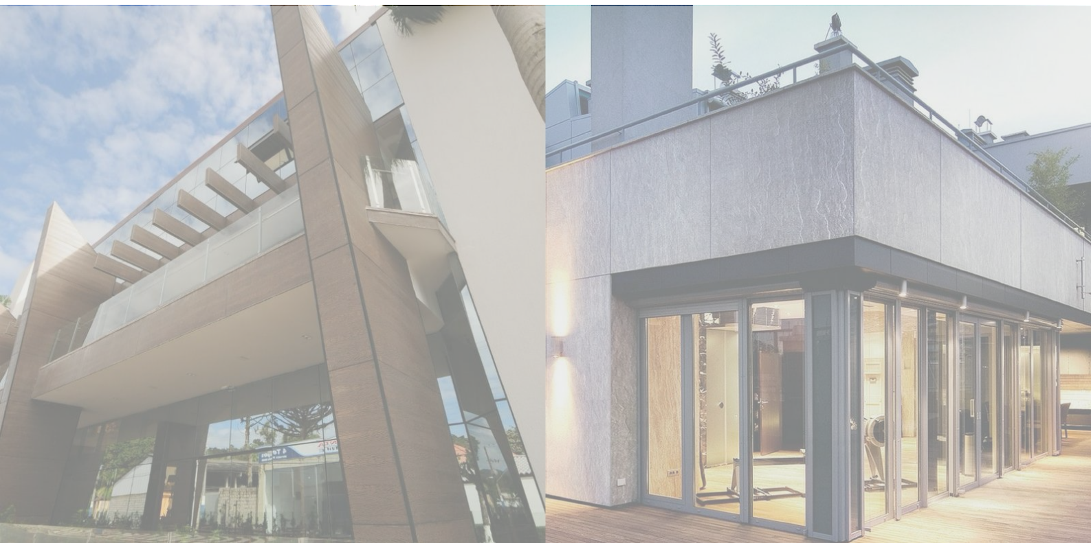
Imagem 10: Placas Cimentícias, produtos que compõem a linha de Sistemas Construtivos Eternit, aplicadas em fachadas de construções comerciais e residenciais.
