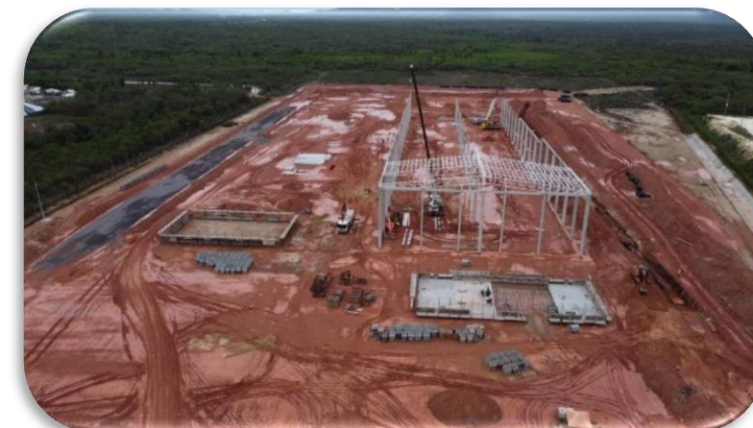
Construção Caucaia-CE (Dez/22)
