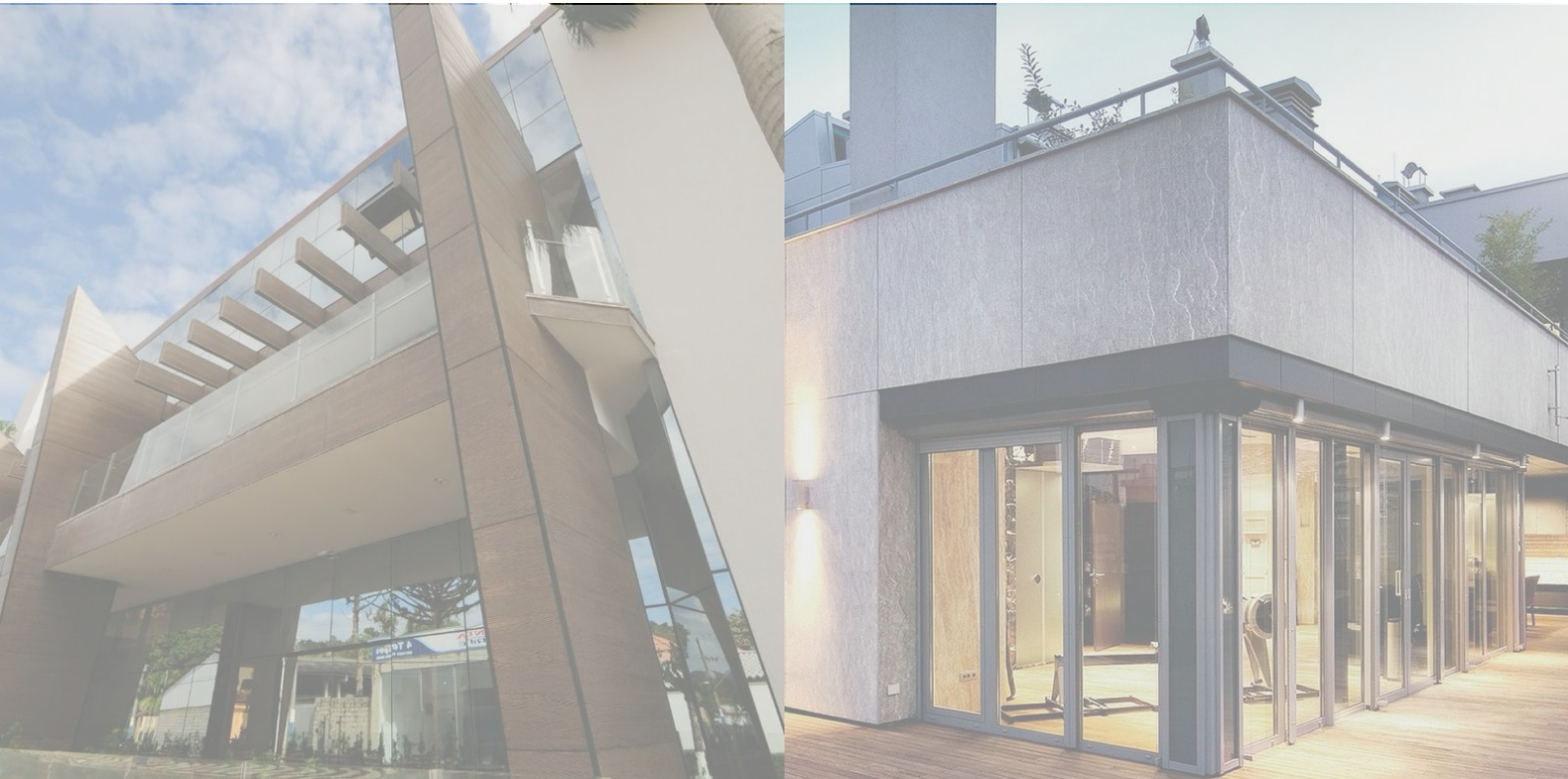
Placas Cimentícias, produtos que compõem a linha de Construção Industrializada Eternit, aplicadas em fachadas de construções comerciais e residenciais.
